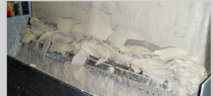
Filterschlämme aus der Prozesswasserreinigung Filter sludge from process water purification
